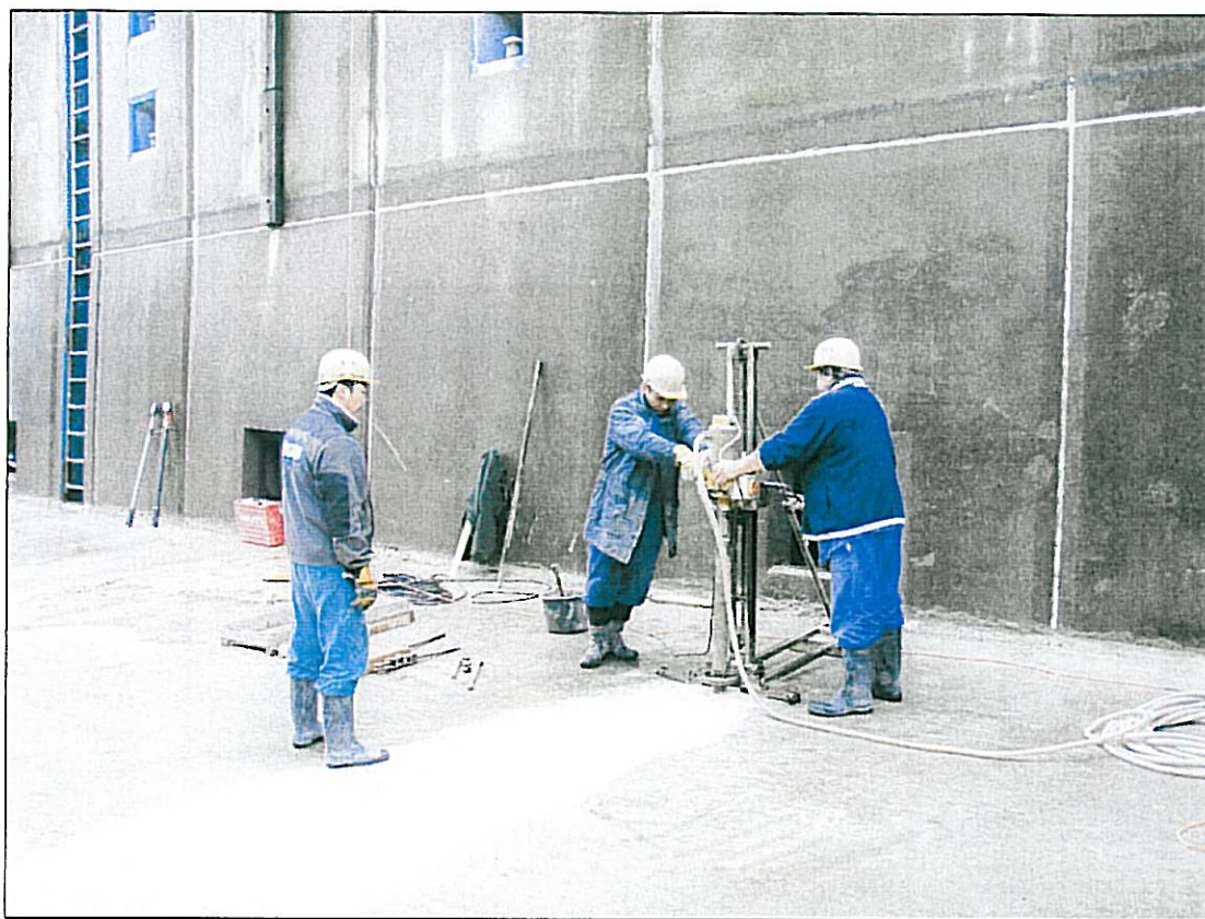
Obr. č. 3: Vrtání vrtu S-4
